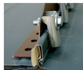
Кронштейн на Кликфальц® (с затяжкой)
